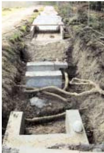
Fundament der Wassergräben mit Wurzelschutzmaßnahmen
